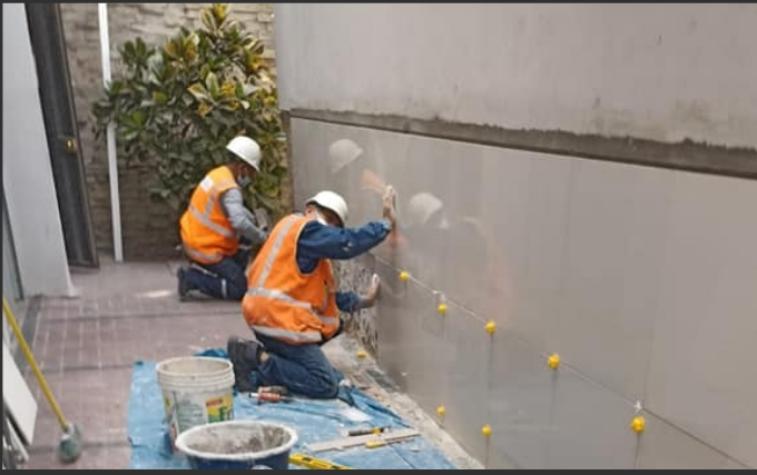
Instalación de acabados
