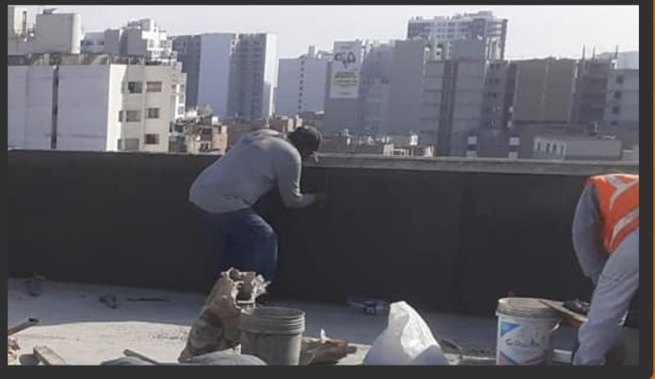
Mantenimiento de paredes
