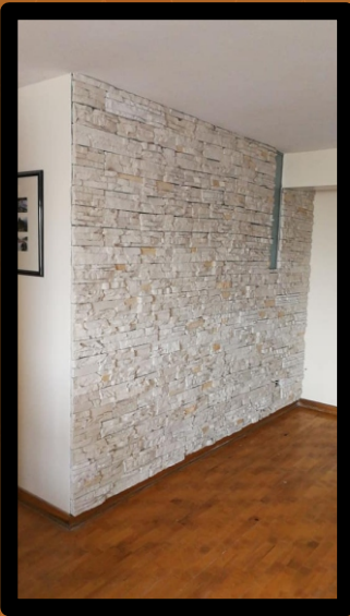
Construcción en seco, drywall y tabiquería
