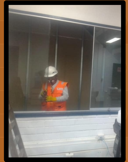
Suministros e instalación de ventanas de vidrio
